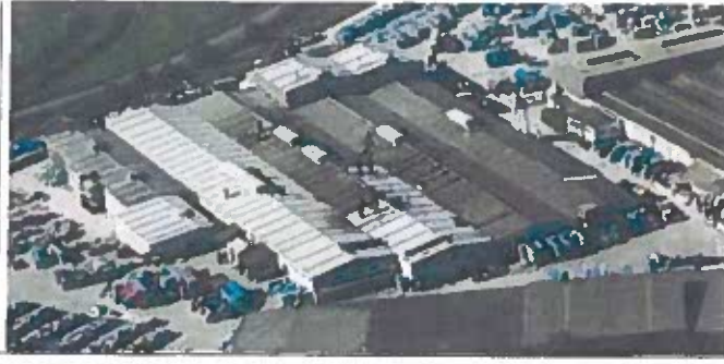
Duvar Karosu Fabrikası -2
